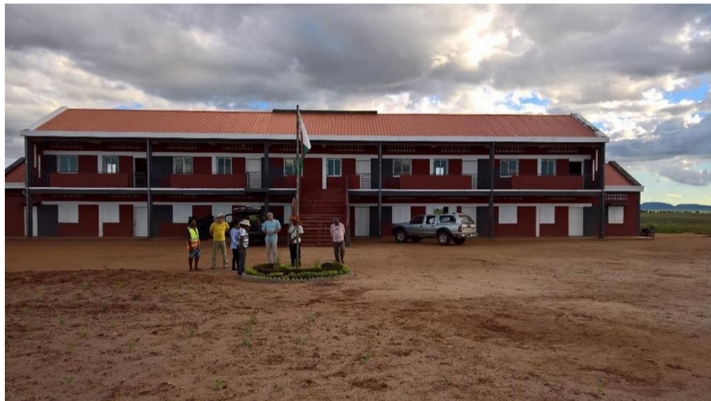
Die Schule wurde 2017 mit externer Finanzierung durch eine christliche Mission gebaut.
